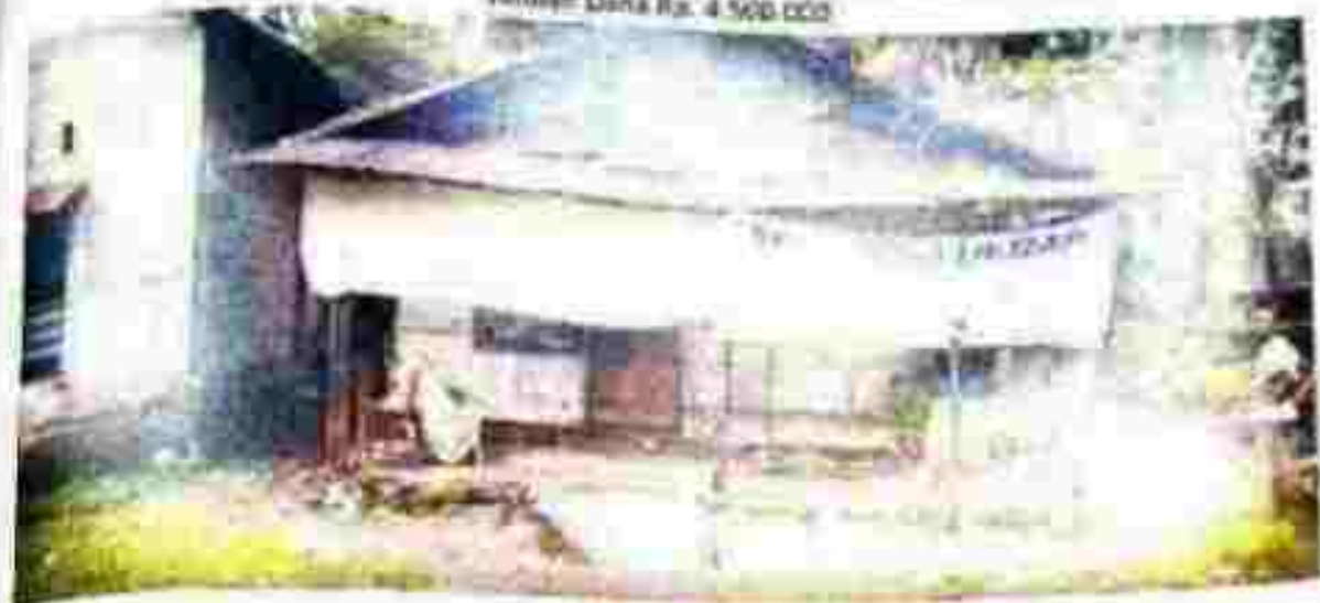
Pembangunan Jamban / WC Rumah An. MANNA Kecamatan Karambung Fasilitas Dana Rp. 4.500.000
